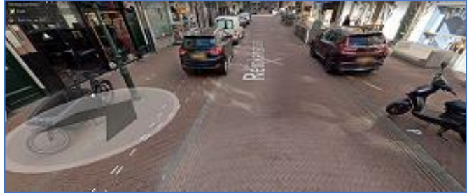
Trottoirband in de Reinkenstraat
